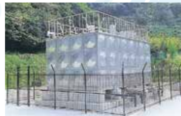
新築した余戸配水池 （佐治町余戸地内）
