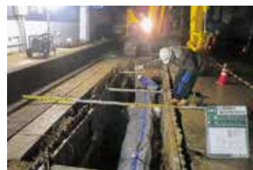
送水管布設替え工事（古海地内）
